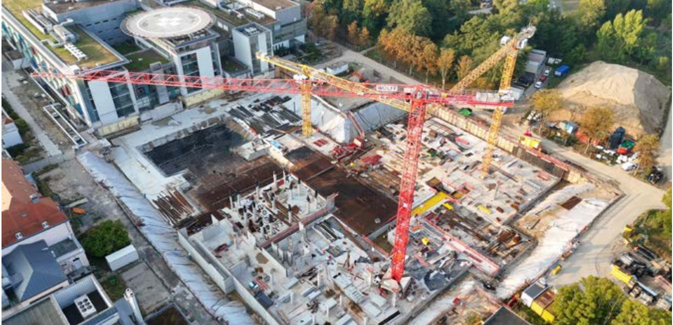
Ein Blick auf die Baustelle des Zentralbaus II.
